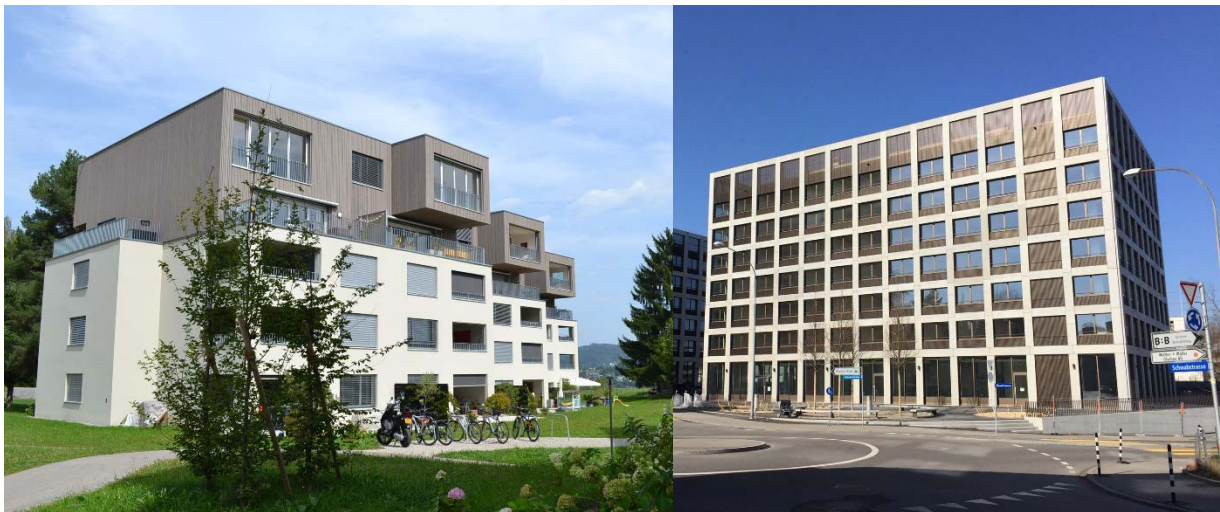
Überbauung Nessleren; Wabern bei Bern
